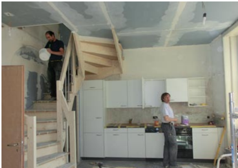
Küche der Frauen-WG kurz vor Fertigstellung
