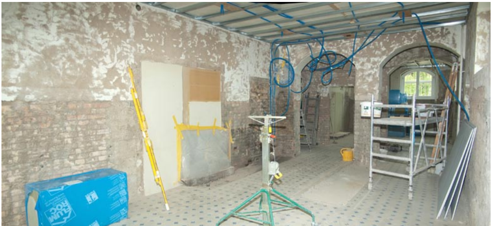
Der Mehrzweckraum im Rohbau
