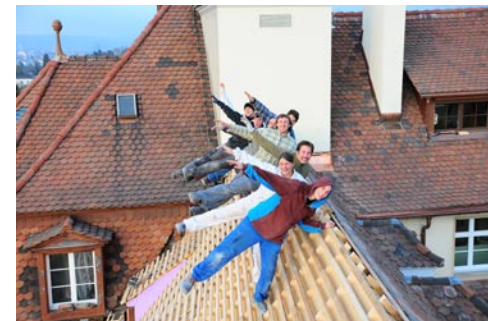
Bauteam mit grossen Dachflächen zum Isolieren und Umdecken
