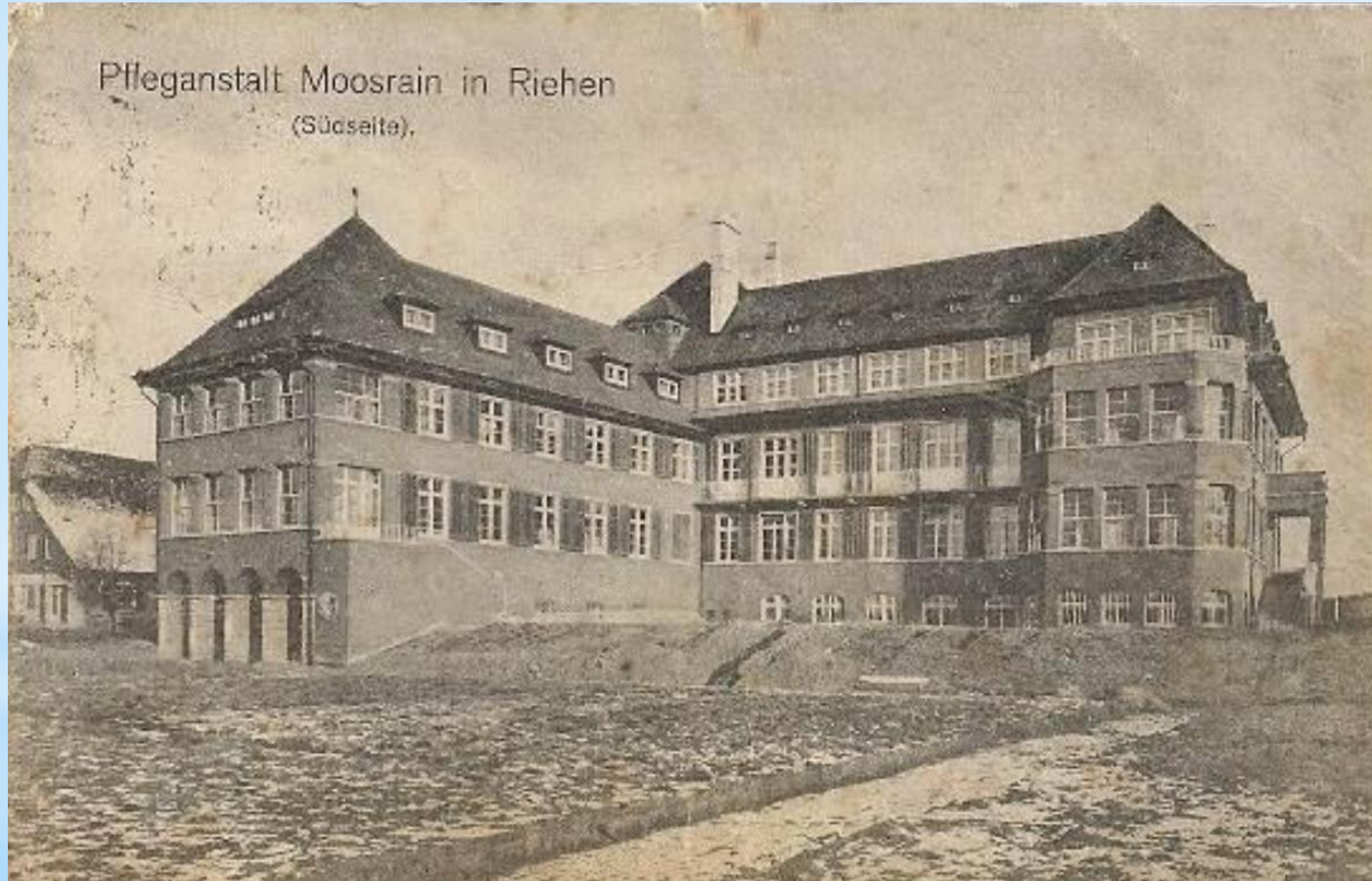
Moosrain 1919, Südseite (Garten ist noch Baustelle)
